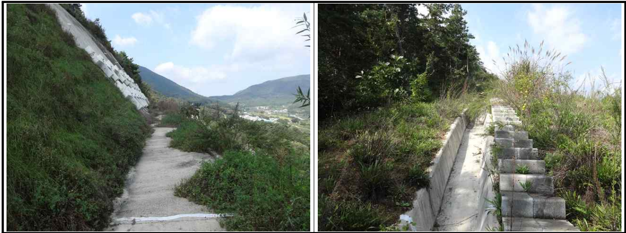
【그림 19.3.3】 배수시설 전경
