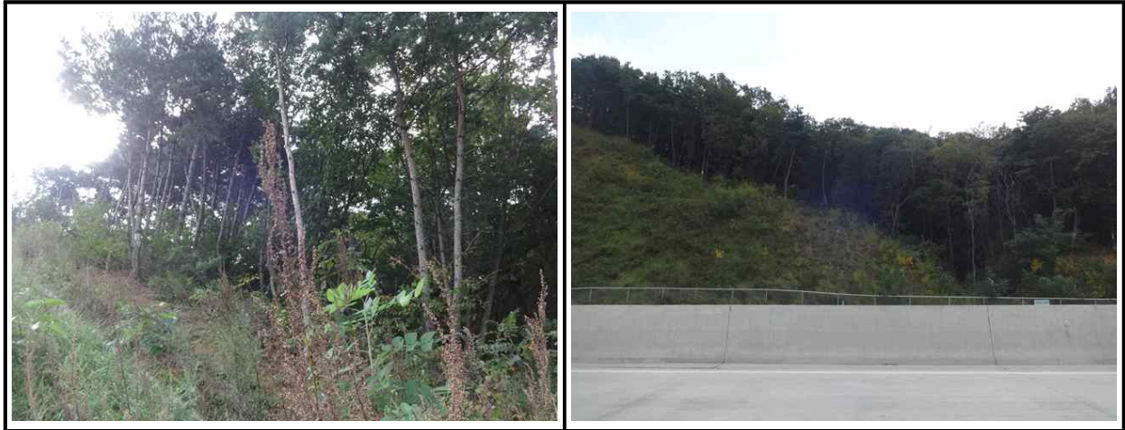
【그림 19.3.1】 상부자연사면 전경
